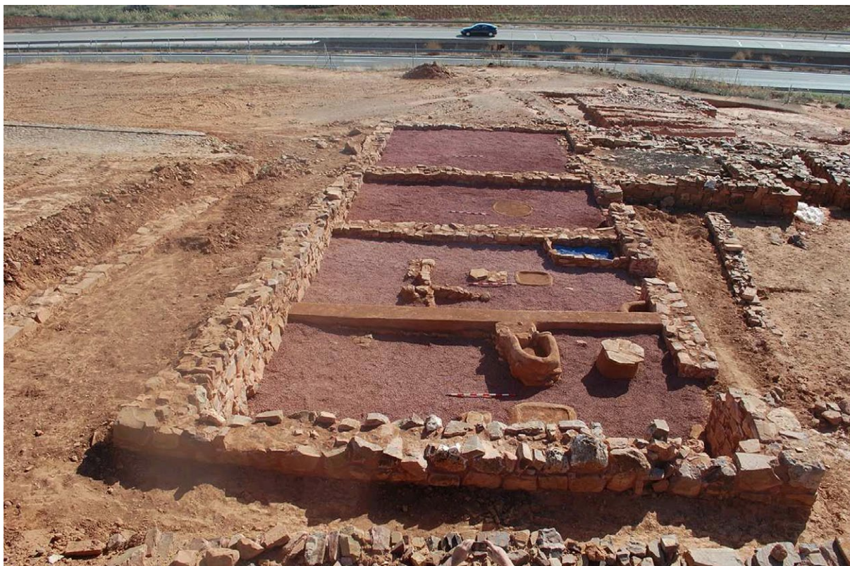
FIGURA 5. Edificio U2 desde el noroeste, tras los trabajos de restauración y consolidación realizados en 2014. GICC.
